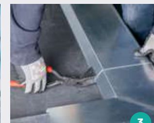
3 Plaats de koppelkap over de 5mm expansieruimte en knijp de waterkering van de koppelkap aan.
