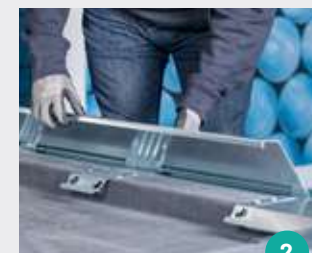
2 Klik de deklijsten op de SnelKlik klangen en houdt een onderlinge afstand van 5mm tussen de deklijsten.
