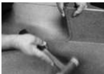
Vervaardiging gootstuk schoorsteen (Fase 3)
