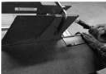
Vervaardiging gootstuk schoorsteen(Fase 2)
