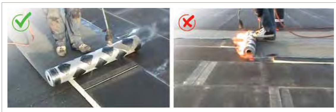
Afbeelding 31 en 32: Aanbrengen van waterdichting met brander op Eurothane Bi-4-platen (Links: Branden op de waterdichtingsrol (gedeeltelijk hechtend membraan); rechts: branden op isolatieplaat)
