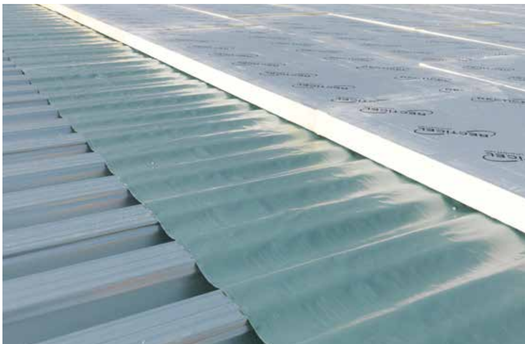
Afbeelding 23: Montage van isolatieplaten op een stalen ondergrond
