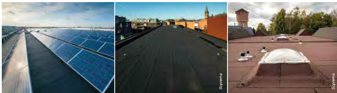
Afbeelding 7, 8 en 9: Bitumineus dichtingssysteem
